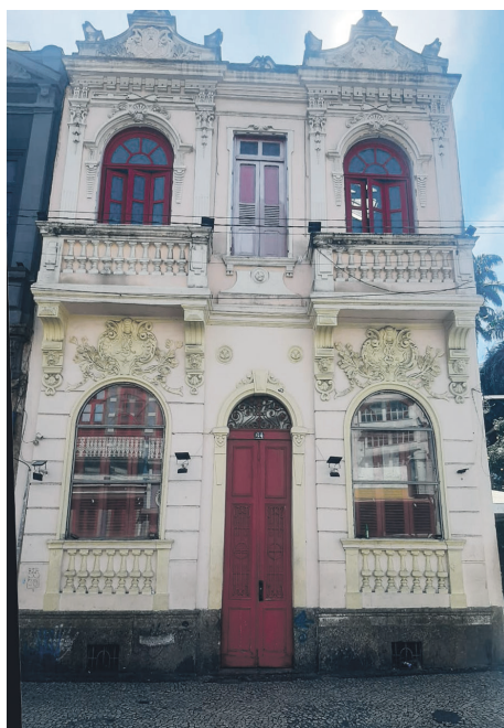
Fachada da obra, onde está o Sarau-Rio
